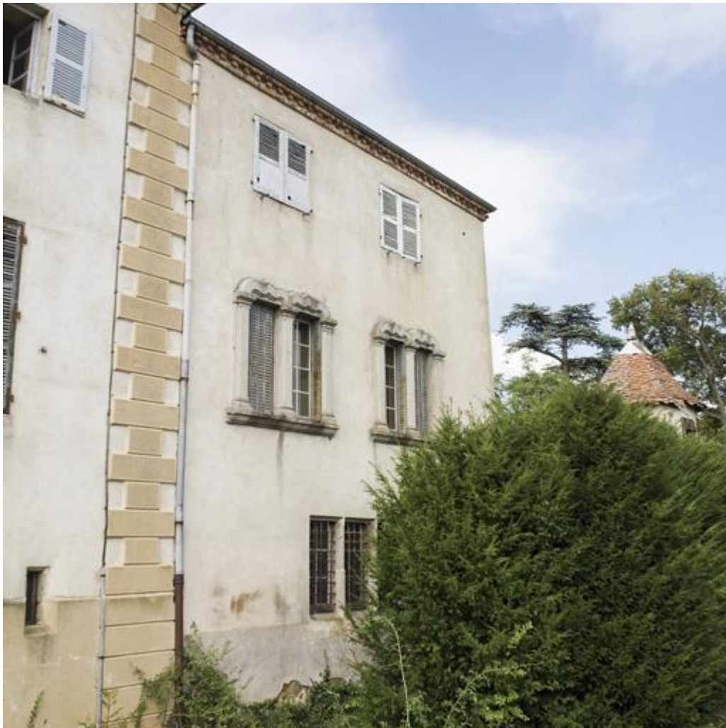
Vue d'ensemble du retour sud du bâtiment principal.
