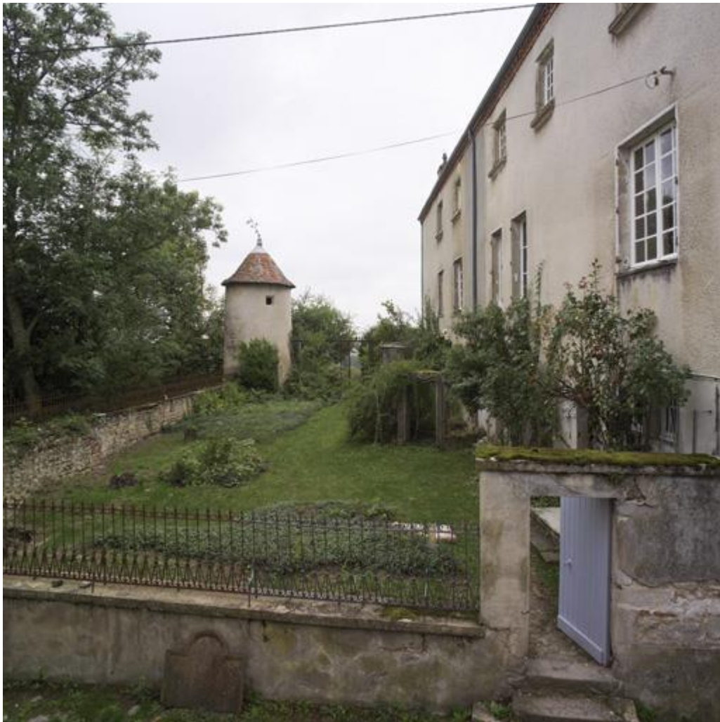
Vue d'ensemble de la cour orientale, depuis le nord.
