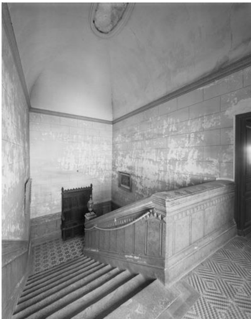
Vue intérieure du grand escalier, depuis le palier du 1er étage.
