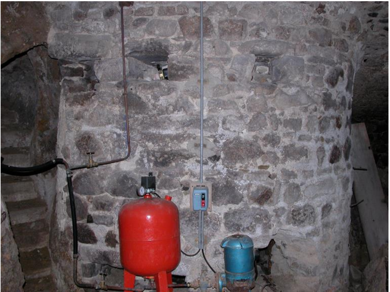
Vue intérieure de la cave : bâti du puits, petit escalier d'accès à la seconde cave.
