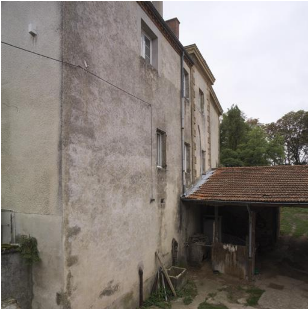
Vue de l'élévation nord, depuis le nord-est.
