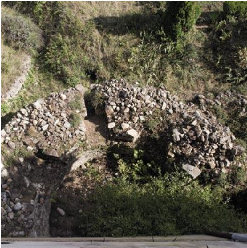
Vestiges de la tour de défense (vue depuis une fenêtre, en plongée).
