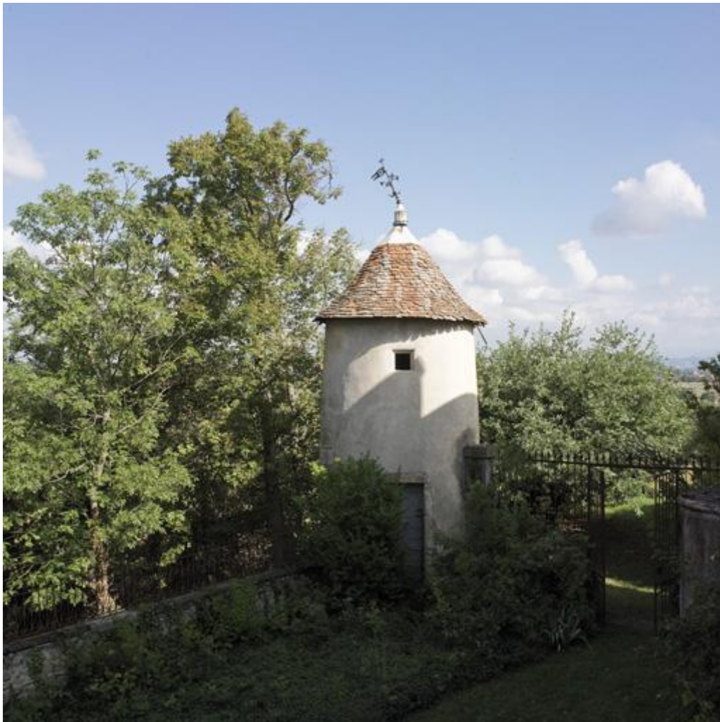
Vue de la tourelle d'angle de la cour orientale, depuis la cour.
