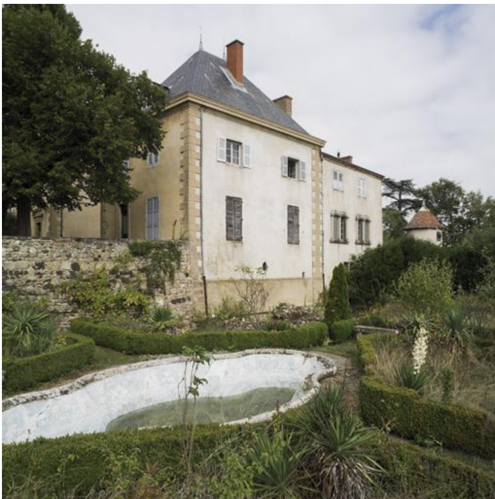
Vue d'ensemble de l'élévation sud, depuis la terrasse sud, au sud-ouest.
