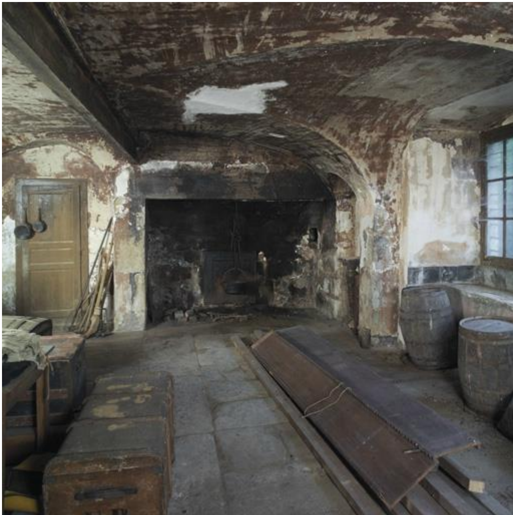
Vue intérieure de la cuisine de l'étage de soubassement : cheminée.
